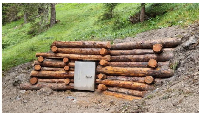
Sanaziun dalla cuvrada dalla combra d'aua a Seglias
